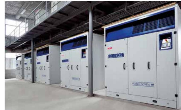
市政污水处理厂: Robox Screw 螺杆压缩机组拥有广泛的调节能力、噪音低、能源效率高。
