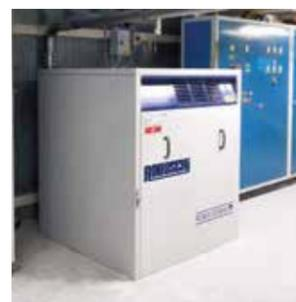
工业领域：著名的意大利面制造商安装了Robox Screw 螺杆压缩机，将其用于面粉和糖的气动输送流程，由于操作温度较低，因而输送的材料不会出现劣化，同时具备高能量性能。
