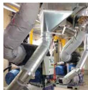
工业领域：WW 酵母生产商使用 Robuschi 的 Robox Screw 螺杆压缩机，以此来促进酵母发酵罐的空气流化。
