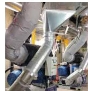
Der weltweit bekannte Hefe-Hersteller vertraut auf Robuschi Robox Screw zur Erzeugung der Verflüssigungsluft für den Fermenter.
